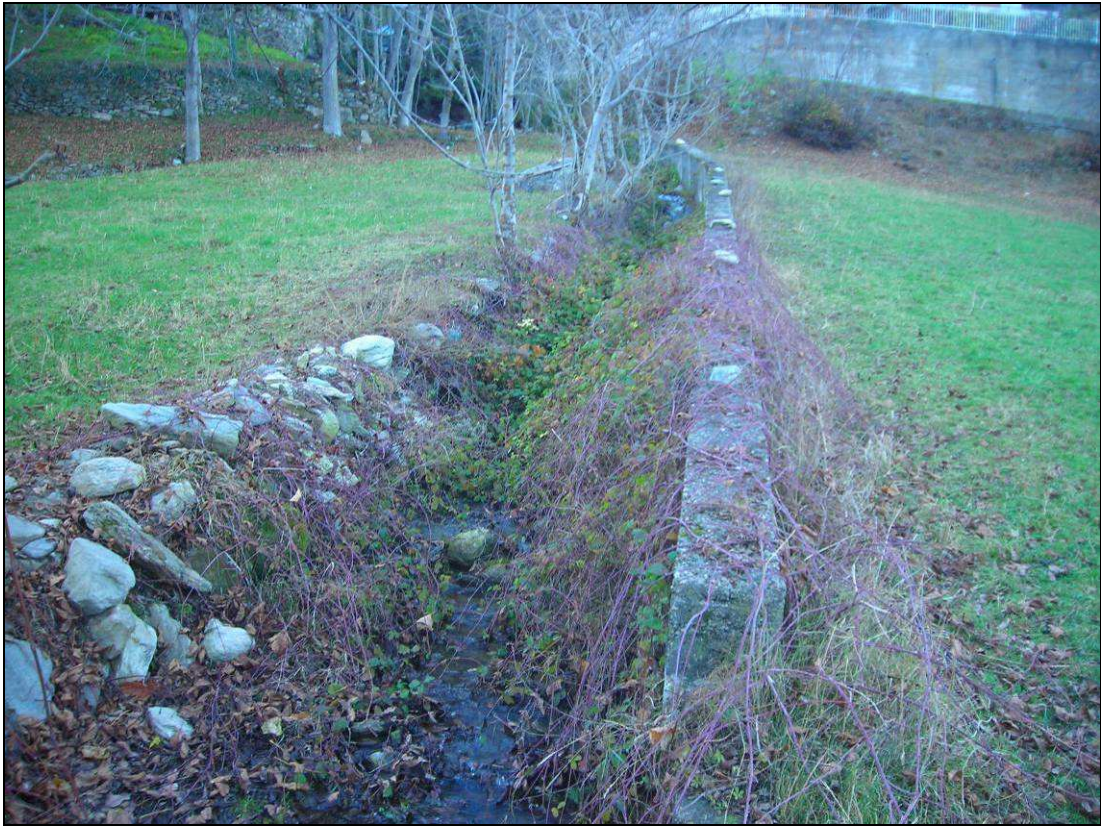
Vista 1 – Tratto a monte della SP 161
