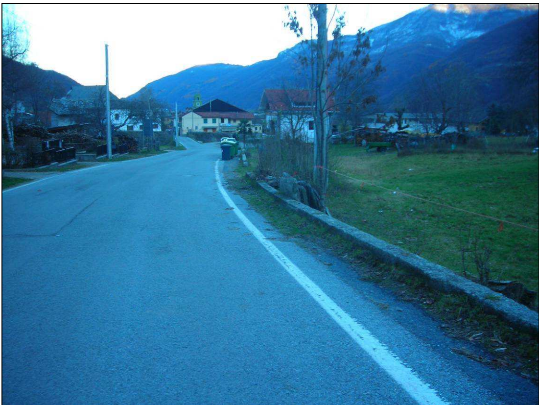
Vista 4 – Tratto della SP 161, con passaggio del rio all'interno di tubi con d = 1.00 m
