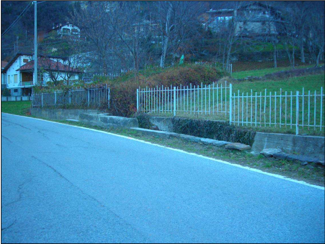
Vista 3 – Tratto della SP 161, interessato dall'attraversamento del rio
