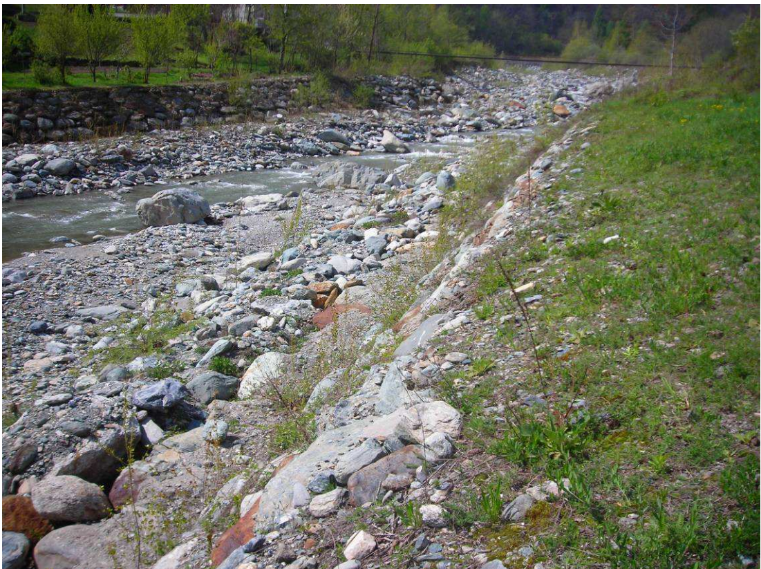
Vista 14 – Tratto di T. Pellice interessato dalla confluenza in progetto del rio Pausette
