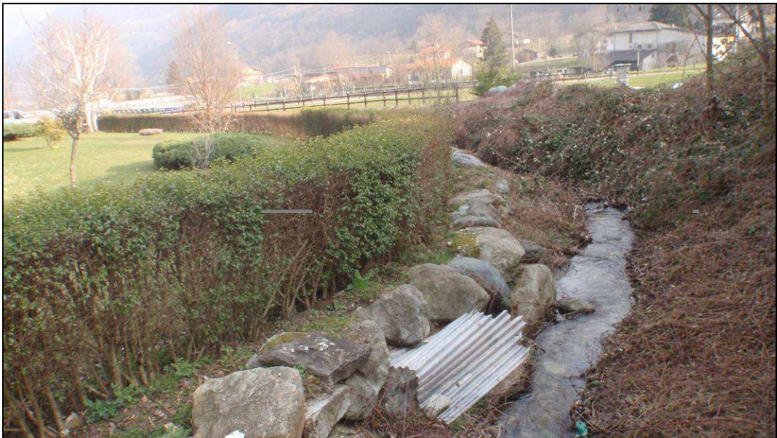
Vista 8 – Tratto a cielo aperto con sponde in massi
