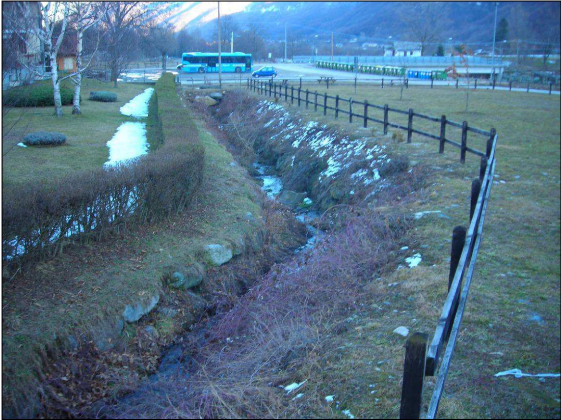
Vista 9 – Tratto a cielo aperto adiacente all'area sosta-camper
