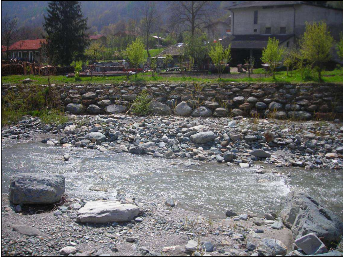
Vista 13 – Tratto di T. Pellice interessato dalla confluenza in progetto del rio Pausette
