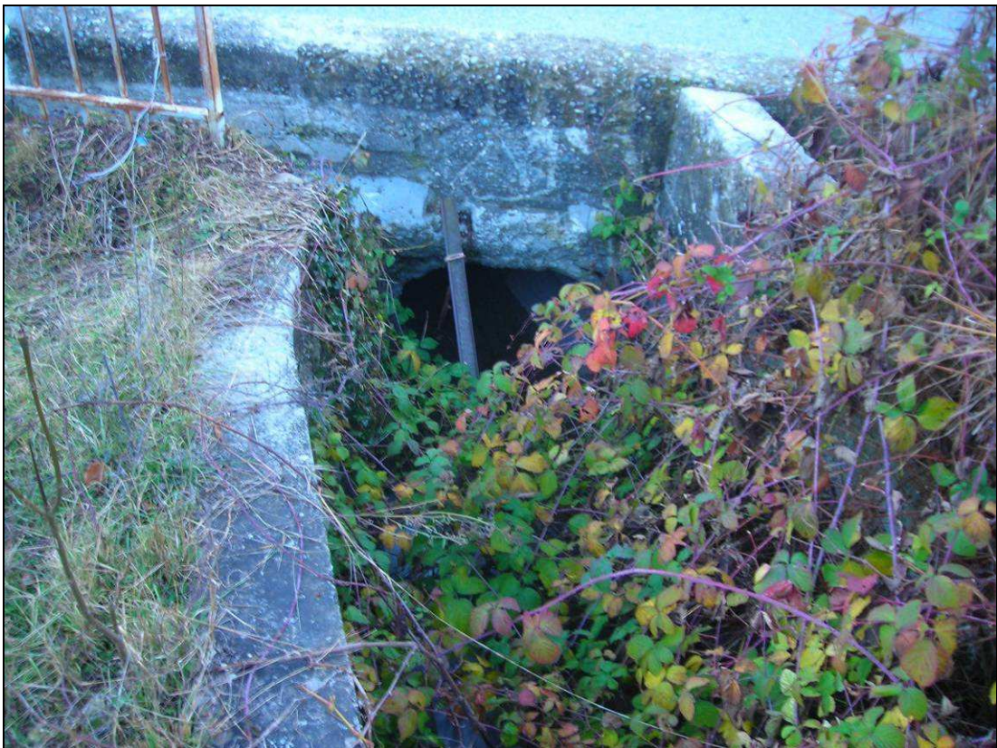
Vista 2 – Intubamento del rio, con attraversamento della SP 161
