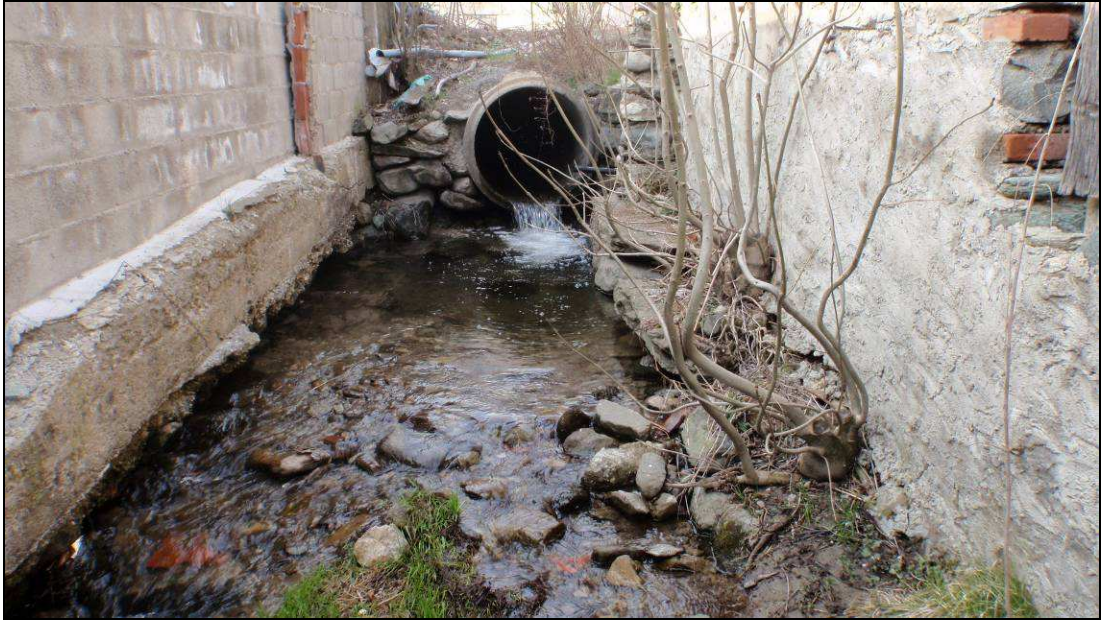
Vista 7 – Tratto tra capannoni, con sponde cementate ed in parte erose (vista da valle)
