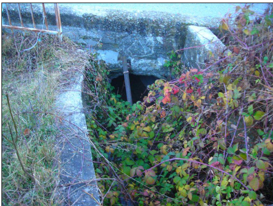
Figura 5 – Rio Pausette, attraversamento sez. 2, presso la S.P. 161 (zona 5)
