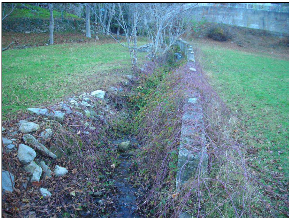
Figura 4 – Rio Pausette, tratto presso la sez. 11, a monte della S.P. 161 (zona 5)
